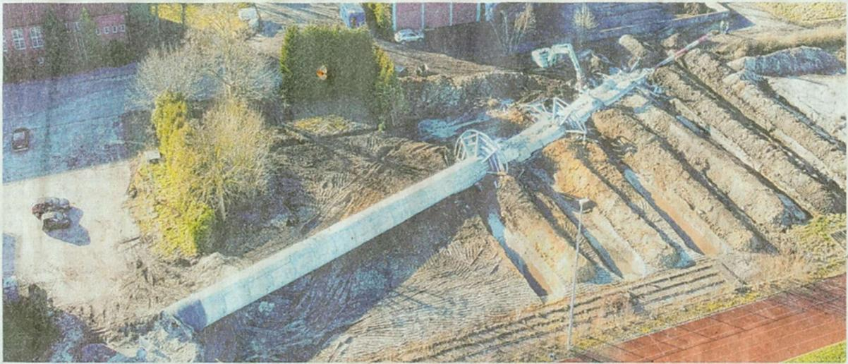
Der Funkturm liegt nach der Sprengung in dem vorgesehenen Korridor. Das Bild wurde mit einer Drohne aufgenommen.
