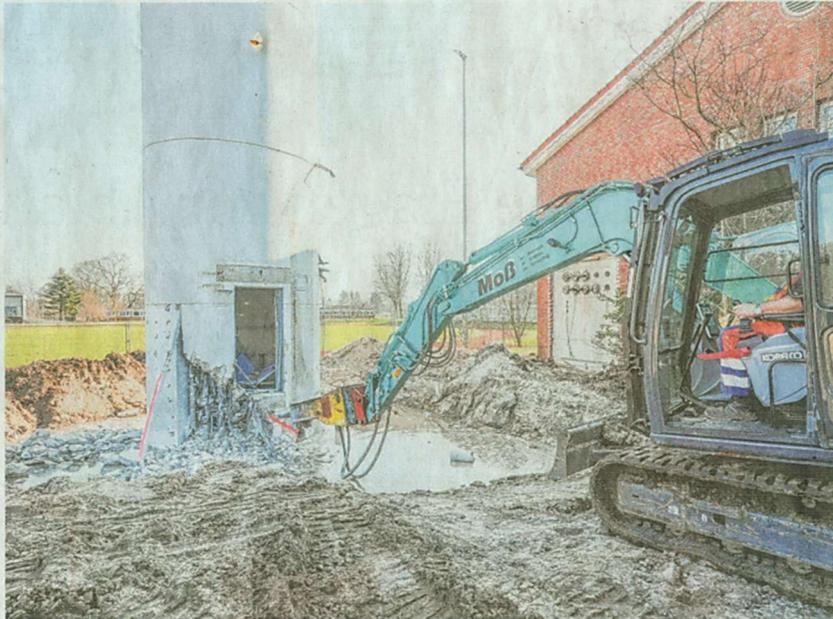
Lautes Hämmern mit dem Bagger: Am Mittwoch wurde der Fuß des 100 Meter hohen Funkturms auf dem Auricher Kasernengelände für die Sprengung am Donnerstag „vorgeschwächt“.
